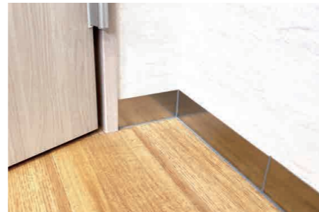
ステンレス スリム巾木 (ブラスト・曲げ加工品)
